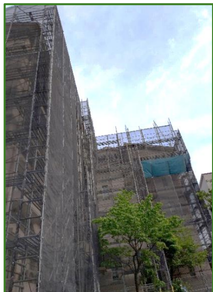
第3次大規模修繕工事始まる
