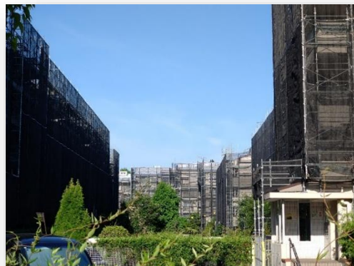
大規模修繕工事の様子
